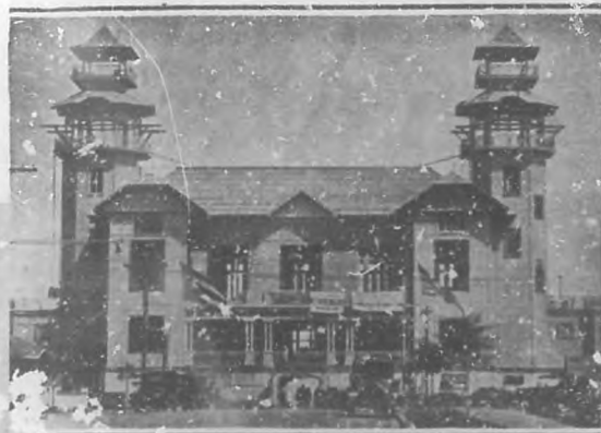
Fachada del edificio, que, en la Playa de Marianao, se está acabando de construir para la sociedad "Miramar Yacht Club".
